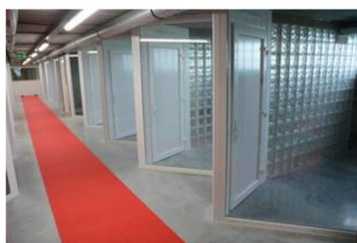
Alle hokken zijn geluiddicht en hebben vloerverwarming. - PKM
